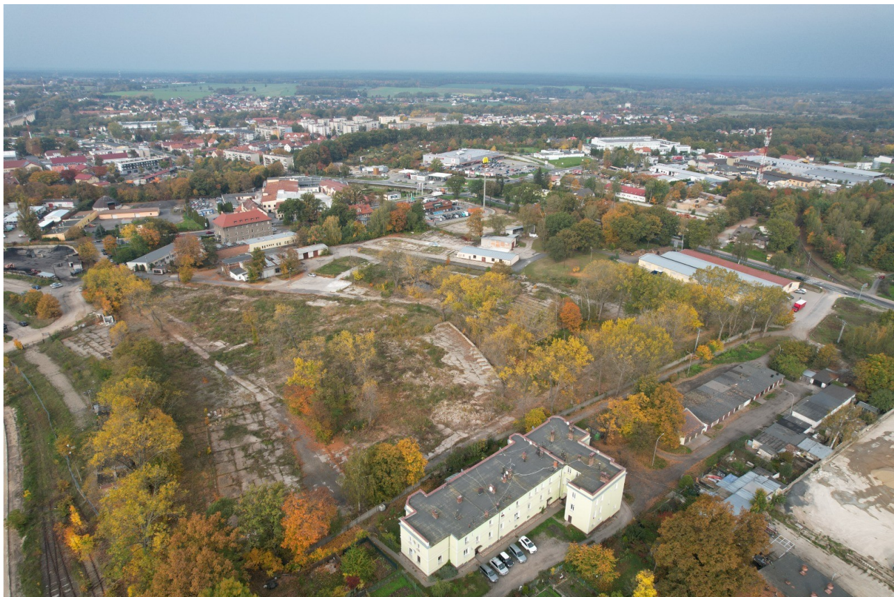
Rysunek 7 Widok z lotu ptaka na działkę będącą terenem inwestycji i jej sąsiedztwo.
